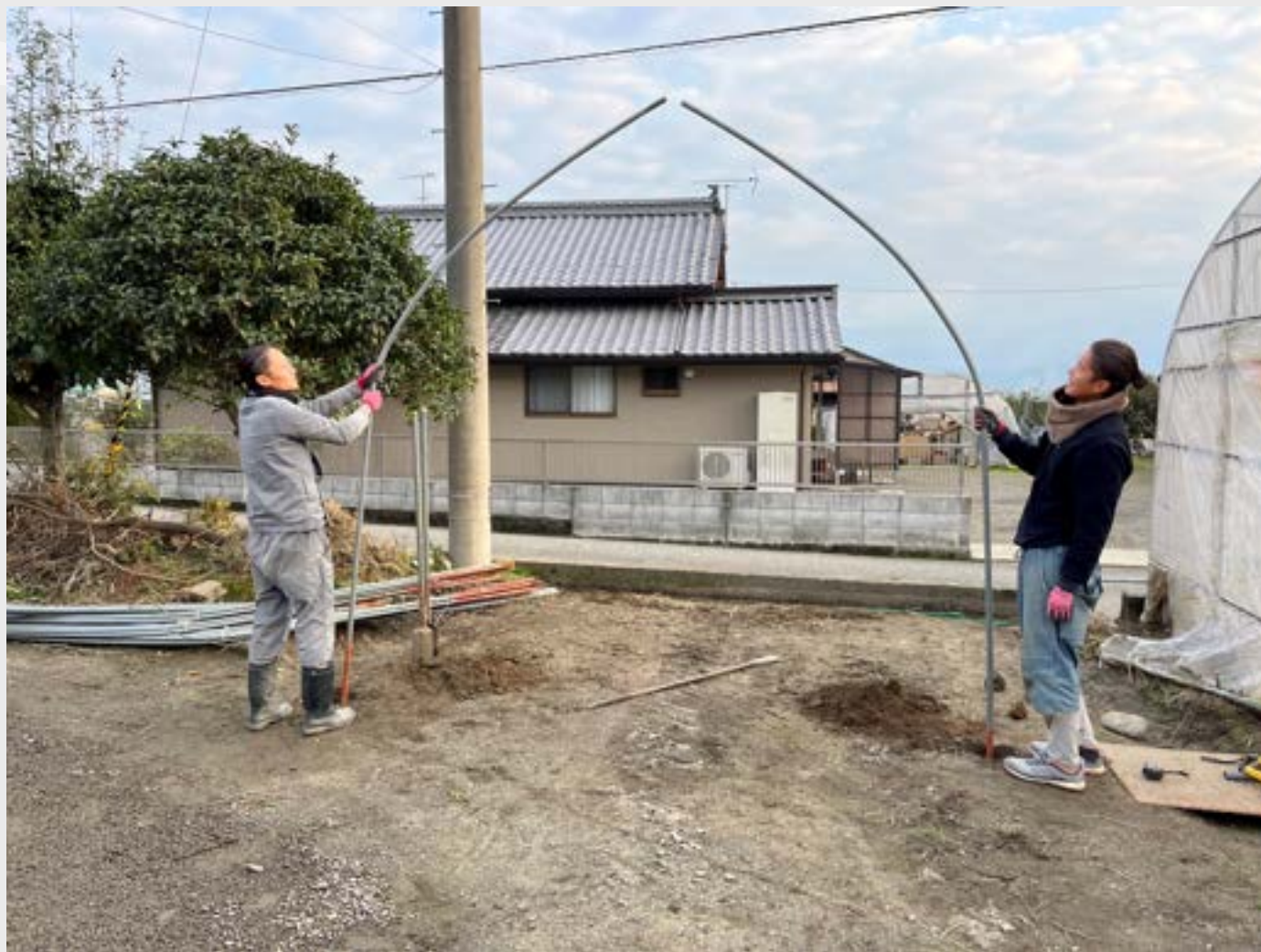
塩ハウスの建設中
